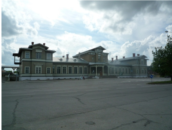
Foto 2. Tartu raudteejaama hoone Vaksali 6, 1876-1878.a., reg nr 7013. 23.05.2013.a. Autor: Merlin Kalle
